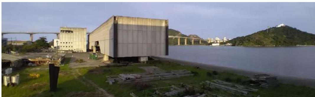
Figura 3: Obra (inacabada) do Complexo cultural Cais das Artes, projeto de Paulo Mendes da Rocha. (Fonte: Botechia, 2023)
